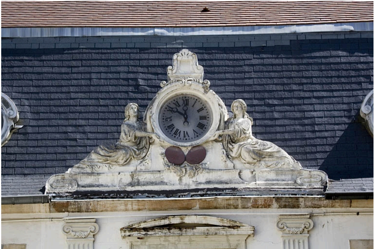
Détail de l'horloge couronnant la partie centrale du logis au fond de la première cour : vue rapprochée.
