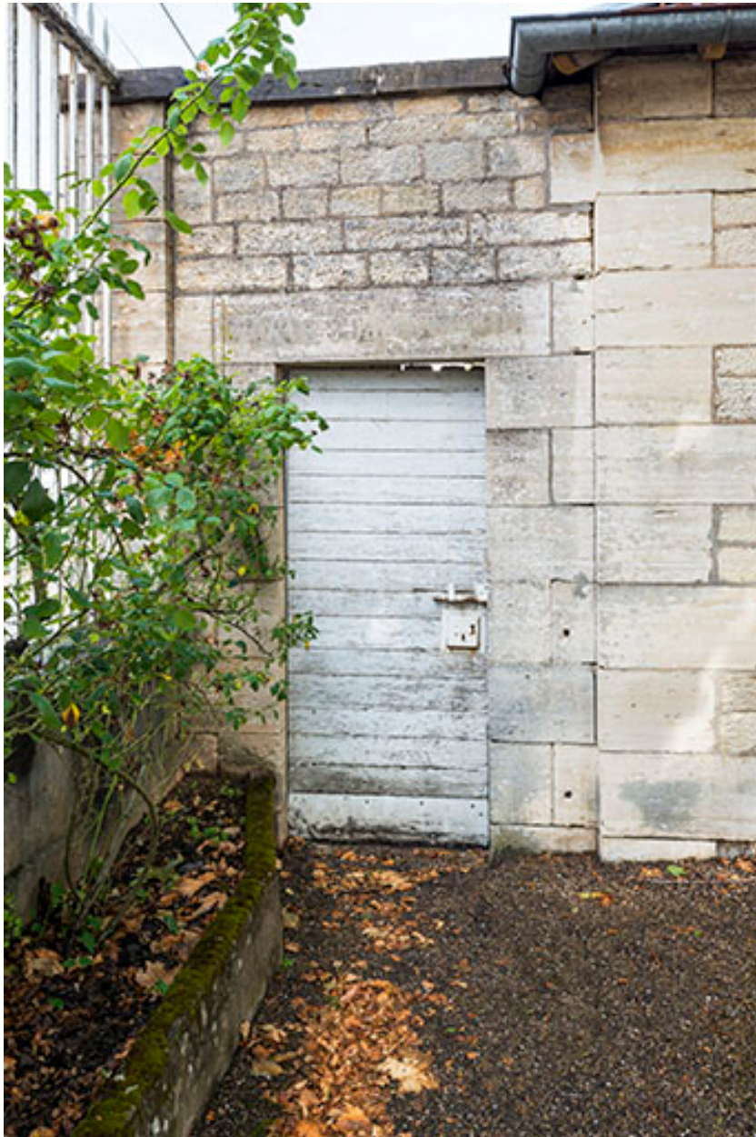
Détail de porte d'entrée au sud-est de l'ancien corps de garde.
