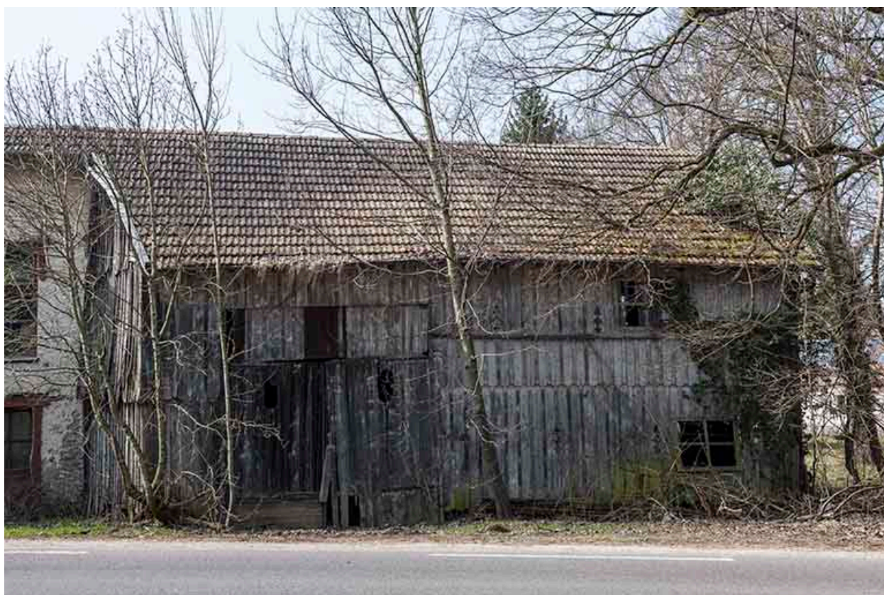
Façade est de l'entrepôt industriel.
