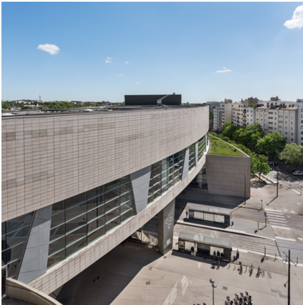
Vue d'ensemble de la façade ouest, depuis le bâtiment au nord.
