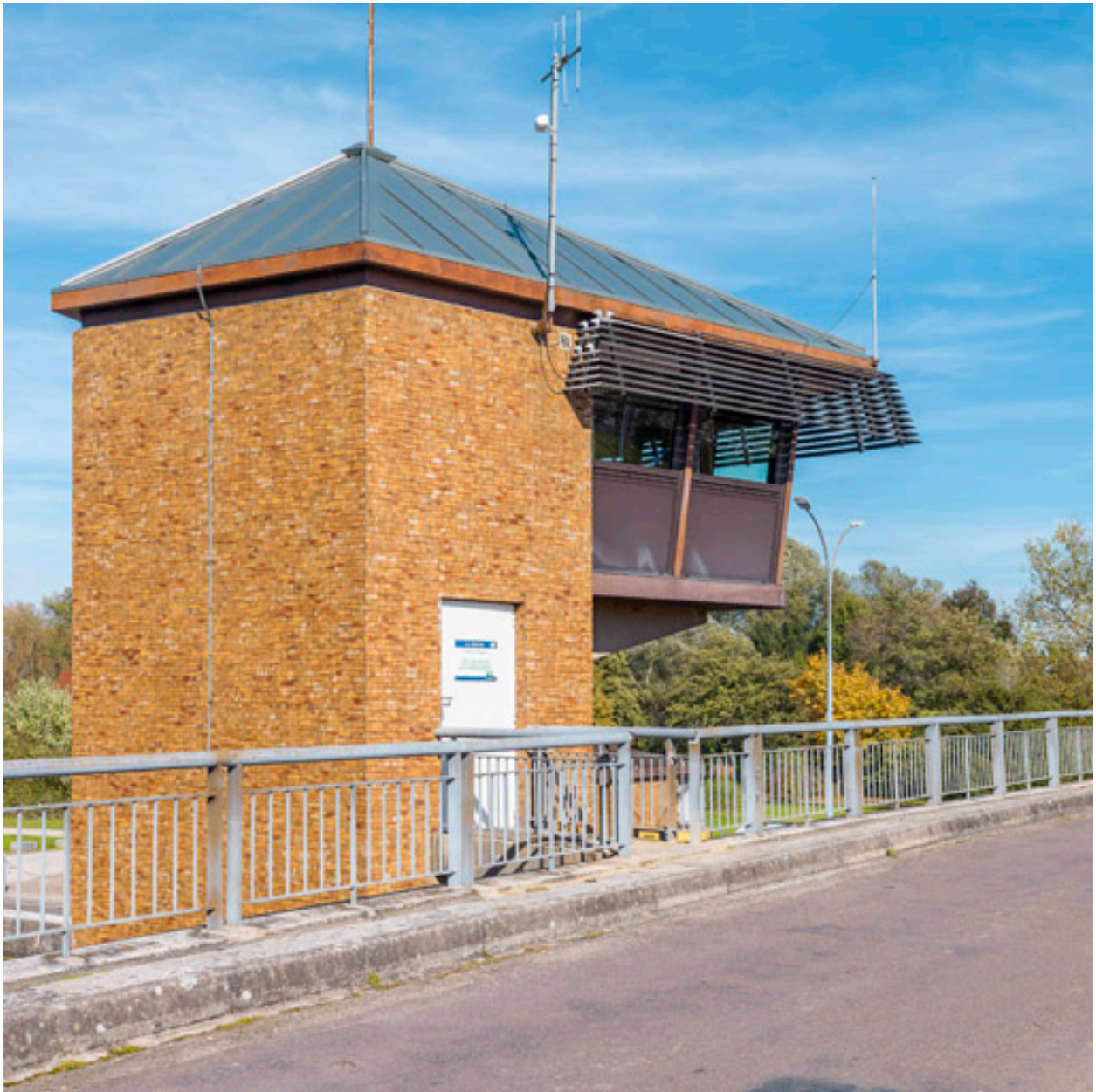
Vue rapprochée de la tour de contrôle.
