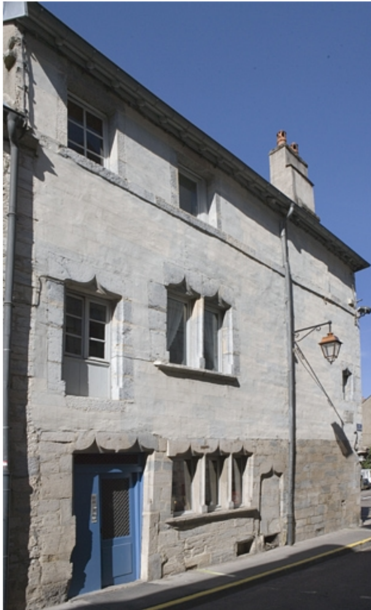
Vue d'ensemble de façade sur la rue Renan, de trois quarts gauche.
