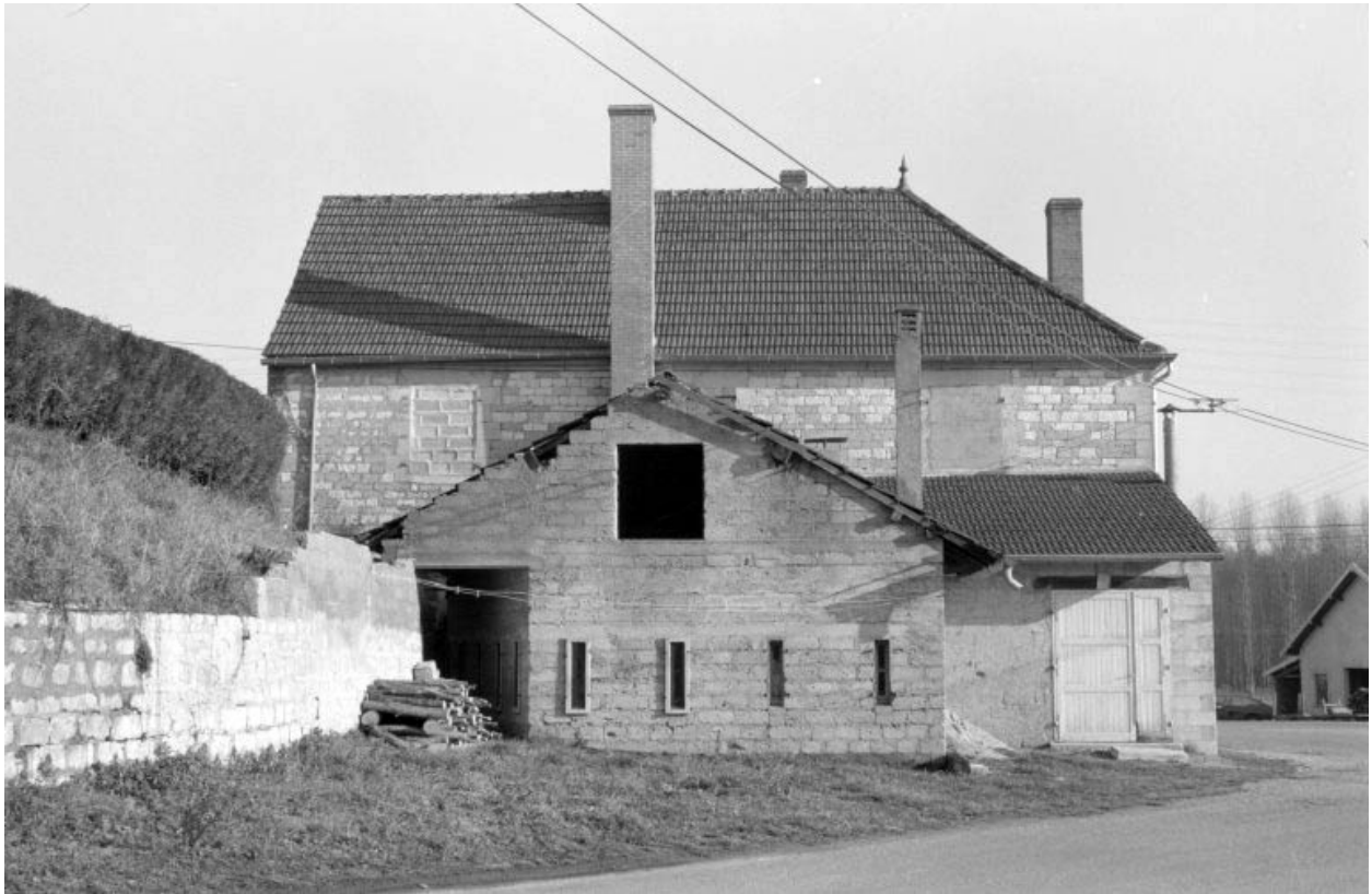
Chambre à lait, depuis l'ouest.
