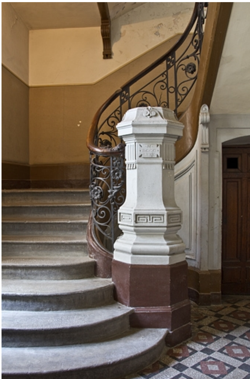
Logis principal, départ de l'escalier dans oeuvre.
