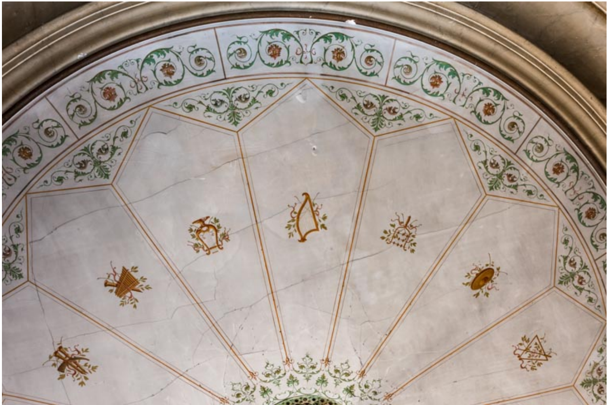
Peinture du plafond : détail.
