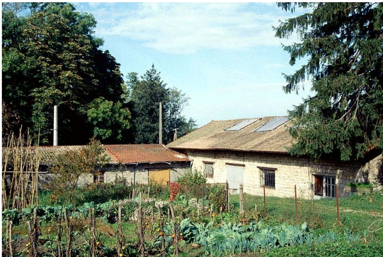
Atelier de fabrication depuis le sud-est.
