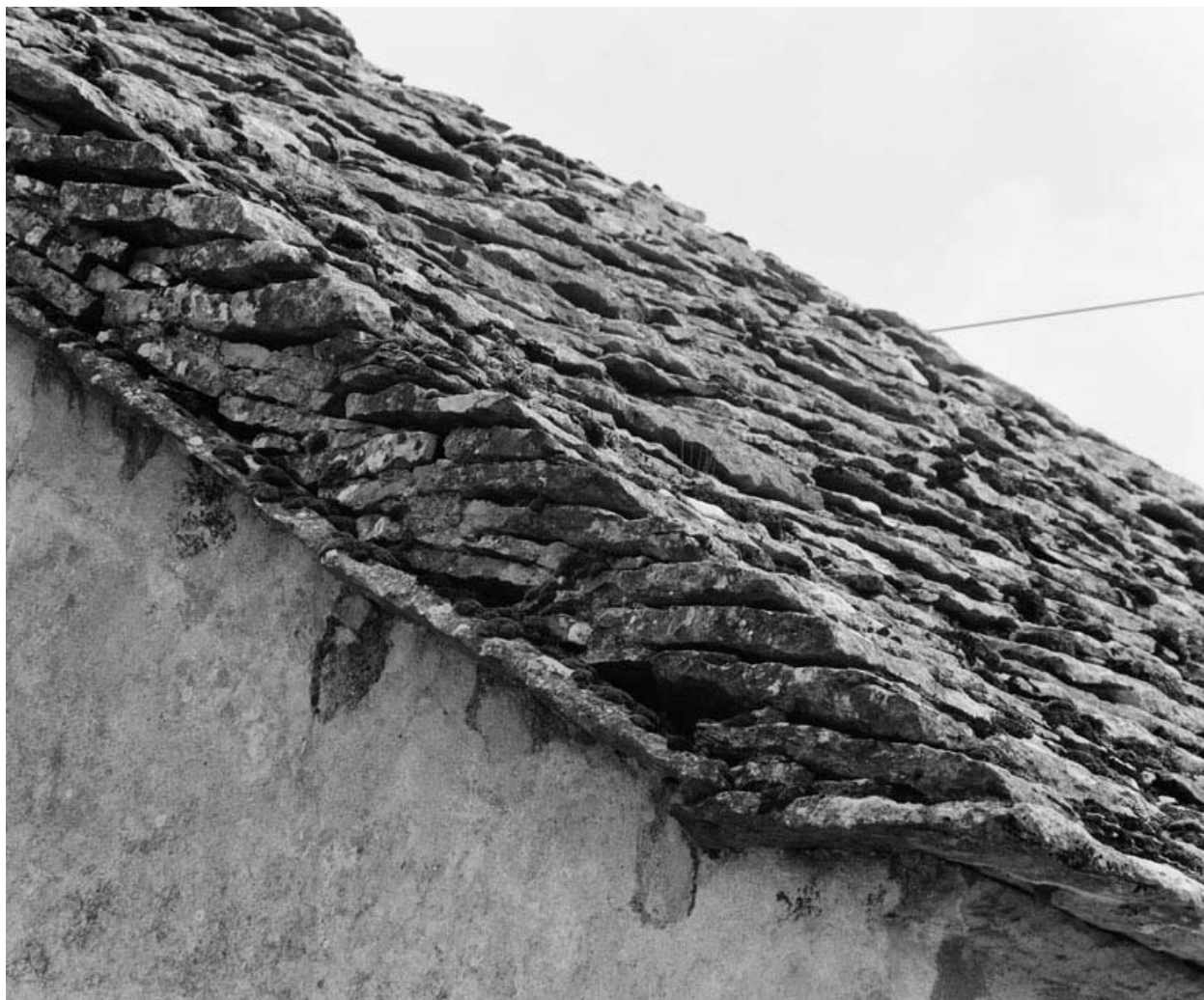
Détail du toit.
