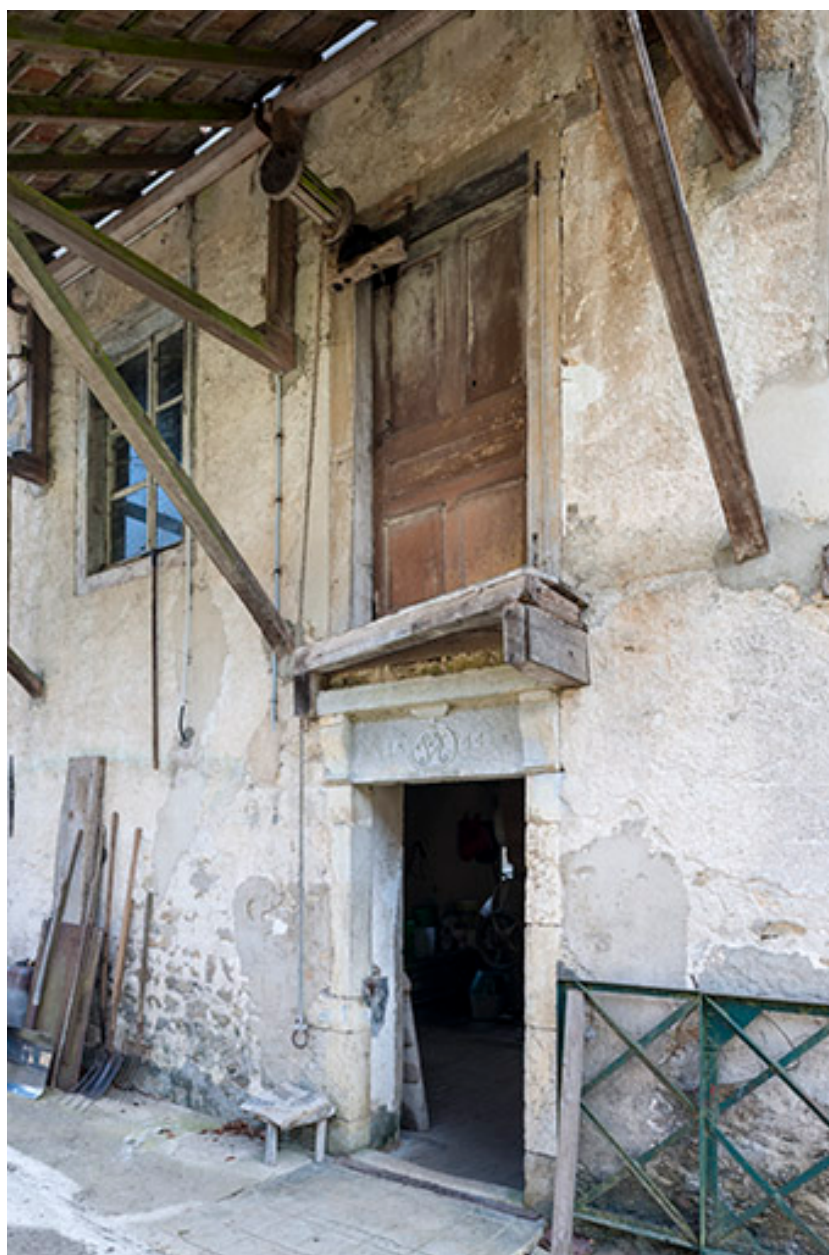
Mur-pignon ouest vu de trois quarts.
