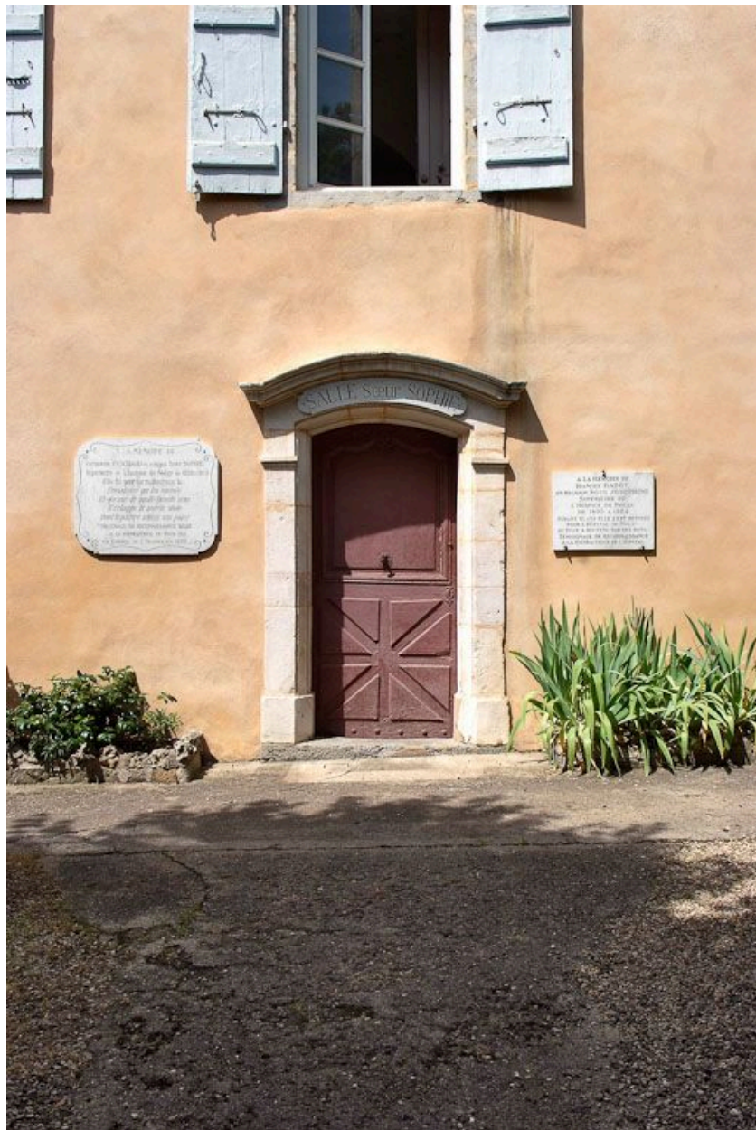
Façade antérieure, détail de la partie centrale.
