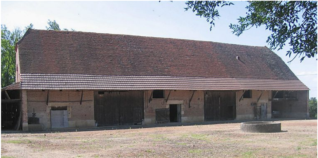
Vue d'ensemble de la façade.
