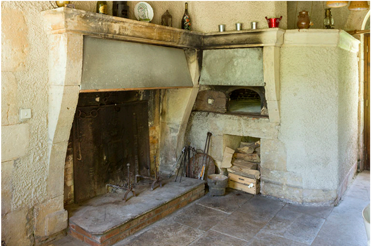
Intérieur du logis : la cheminée de la cuisine et le four à pain.
