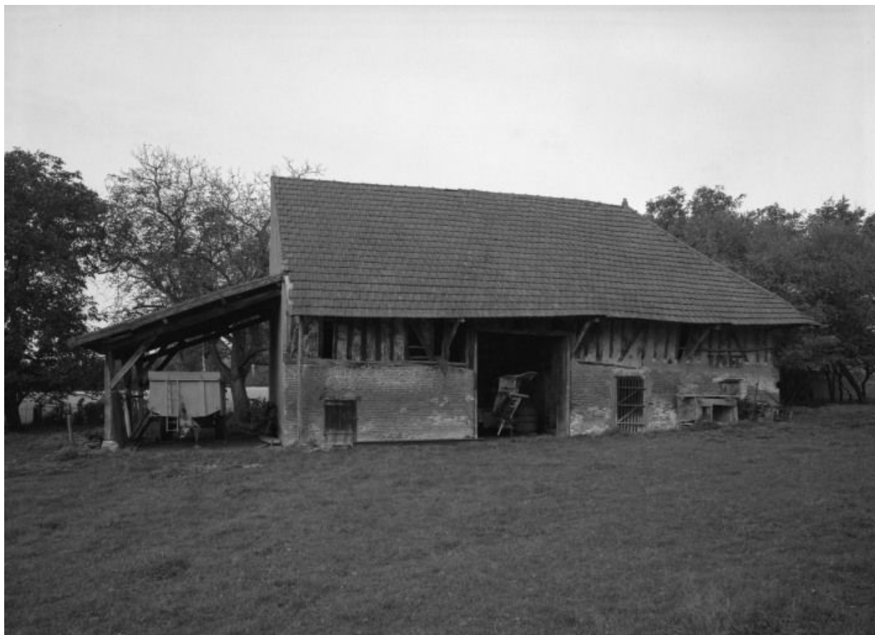
Bâtiment des dépendances.
