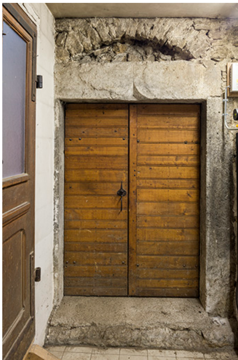
Porte de la cave (dans la chaufferie au nord).
