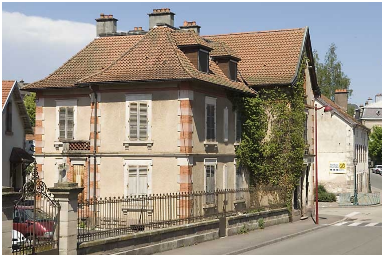
Logement patronal vu de trois quarts.
