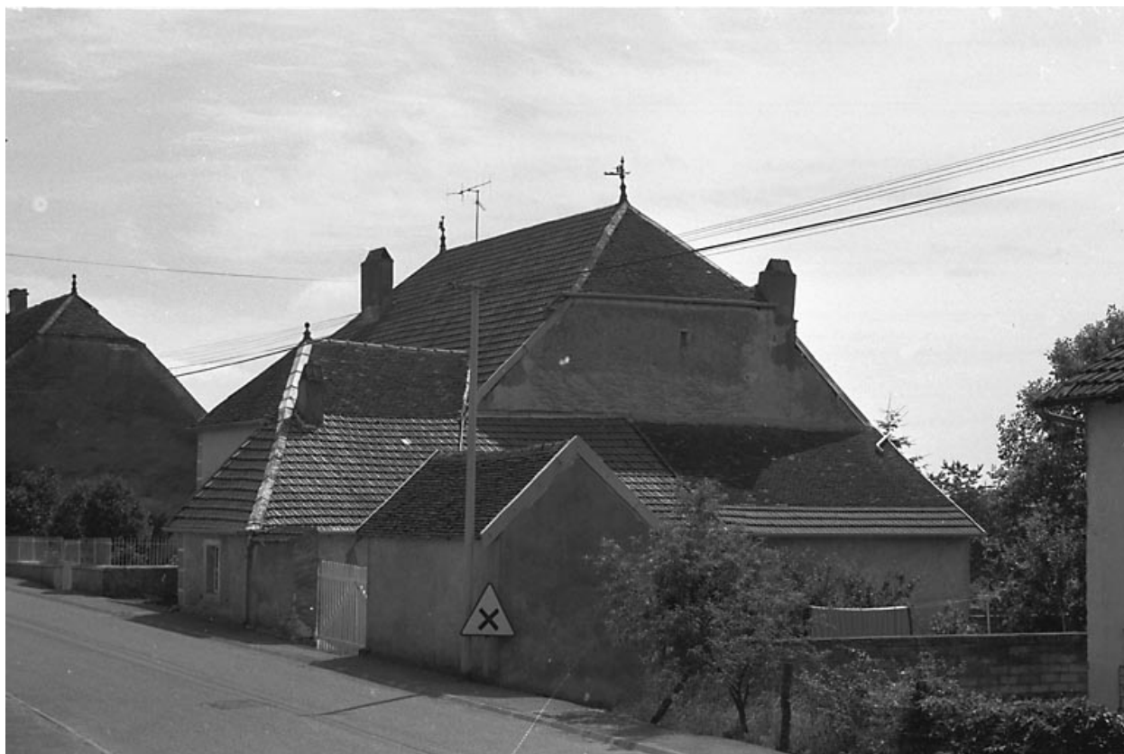
Façade latérale droite.
