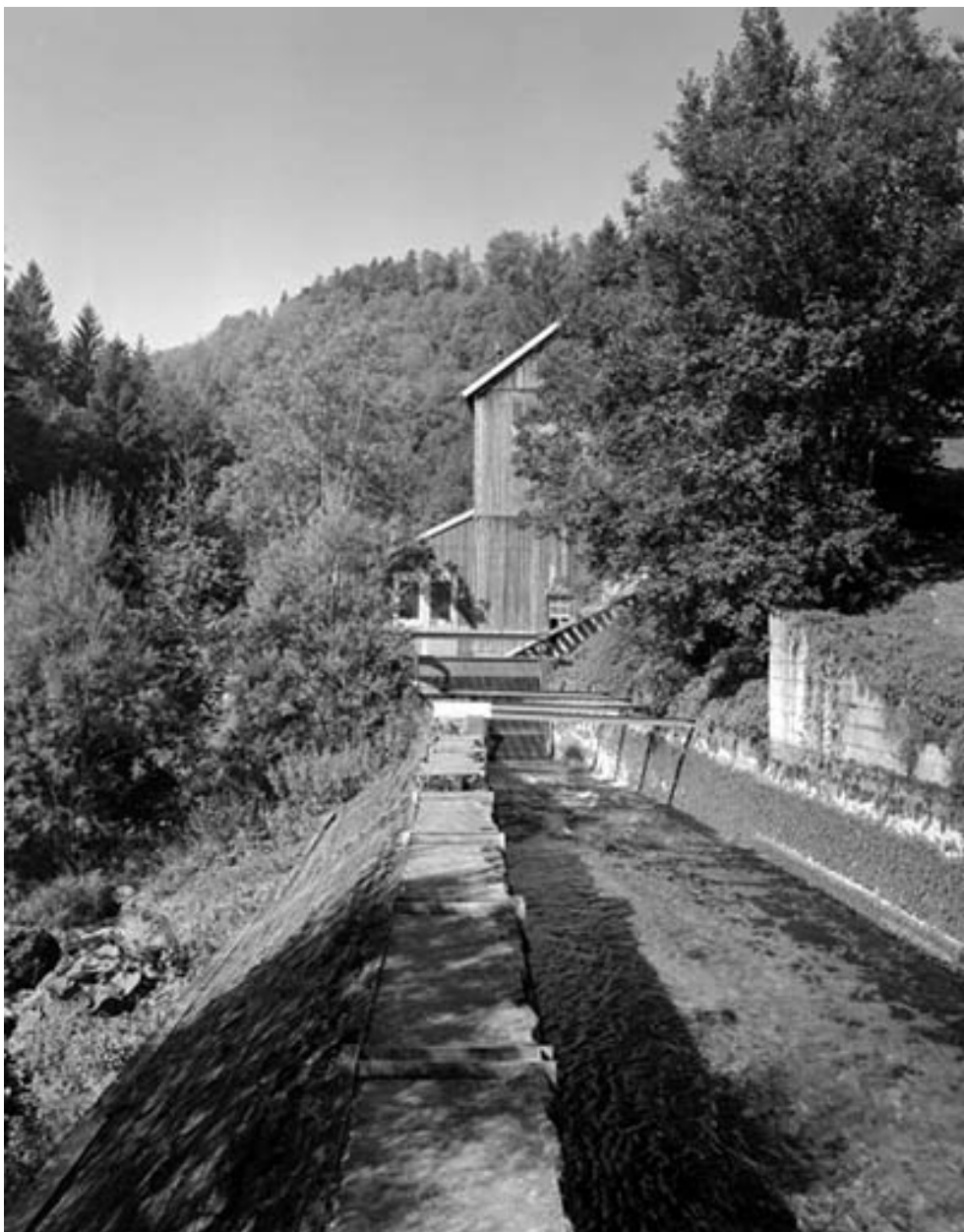
Canal d'amenée de la centrale hydroélectrique.
