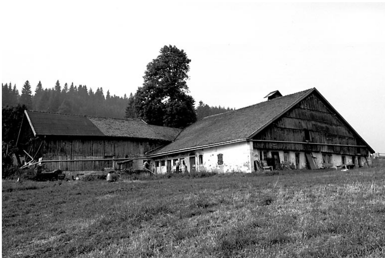
Vue d'ensemble, face nord.
