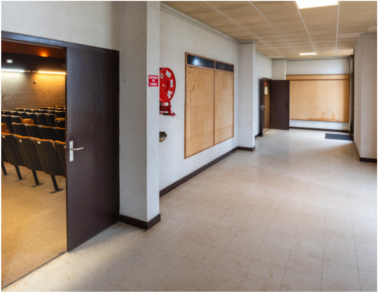
Couloir (ancien promenoir) et accès à la salle.
