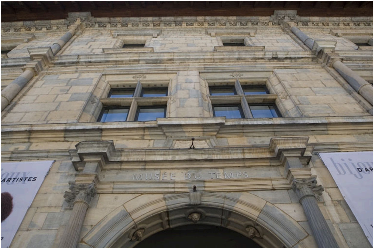
Façade principale : détail de la travée centrale à partir de l'arc du portail.
