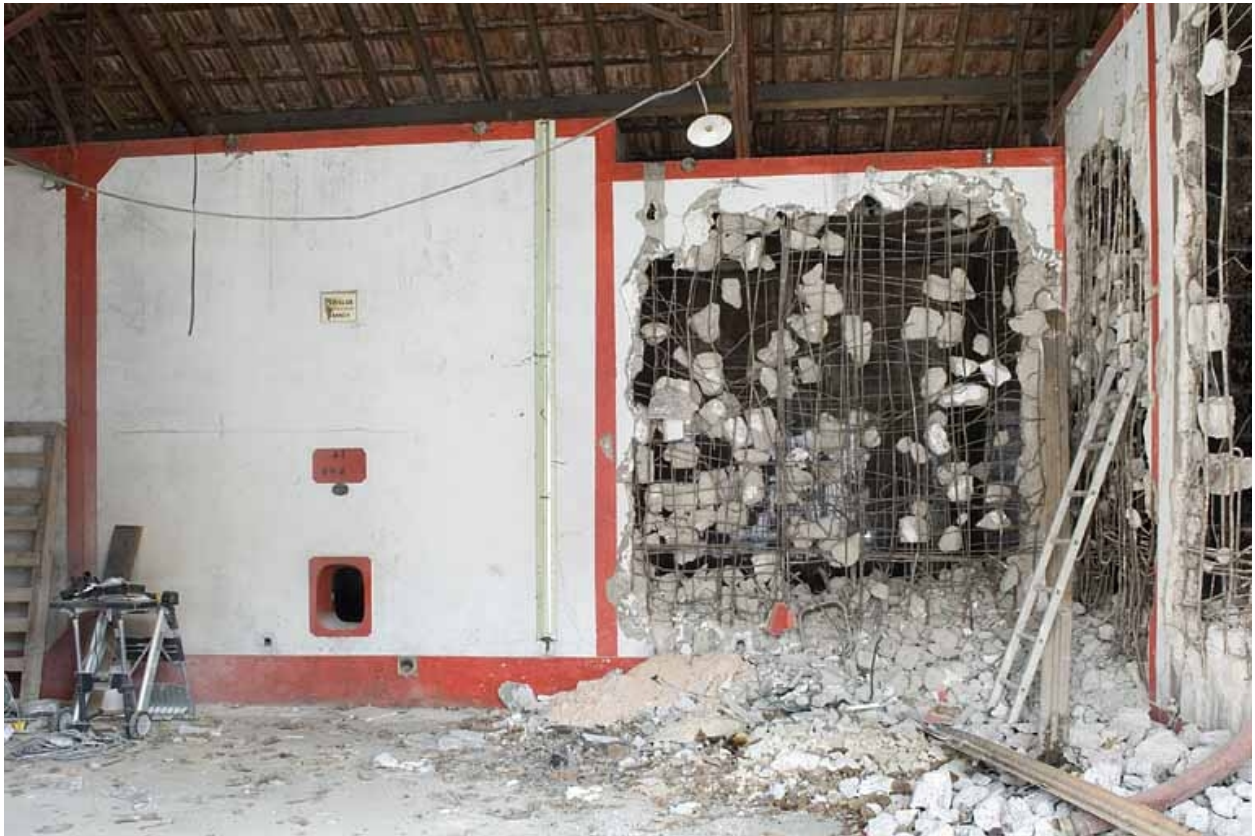
Cuverie. Cuves de fermentation en cours de démolition.
