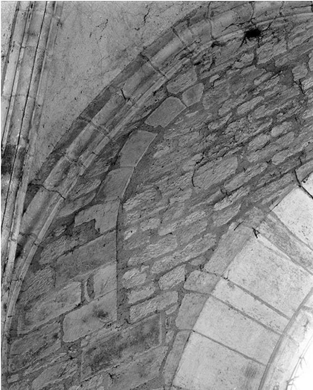
Choeur, mur droit : vestiges d'une ancienne baie.
