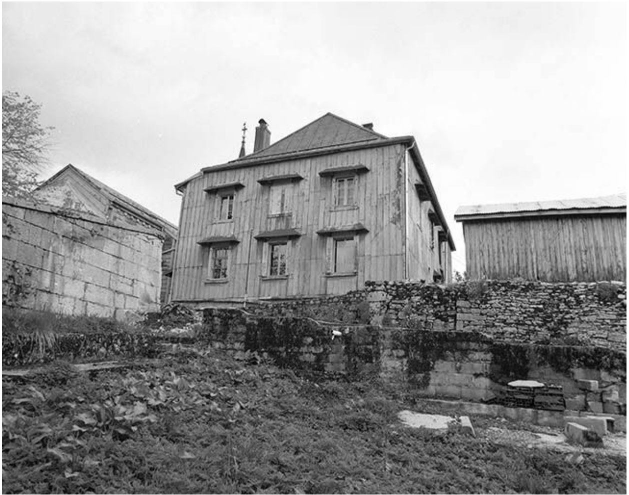
Vue éloignée de la façade ouest.
