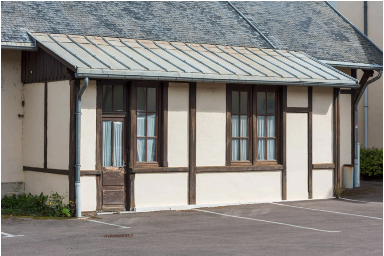
Extension en appentis (sacristie ?). Vue de trois quarts.
