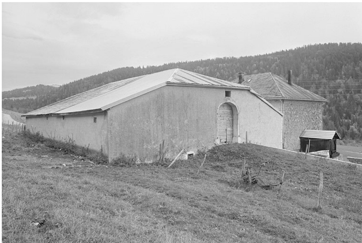
Face sud-ouest et façade postérieure.
