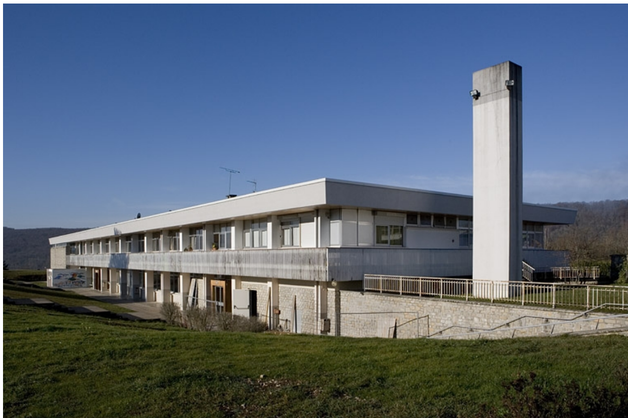
Vue d'ensemble de l'internat.
