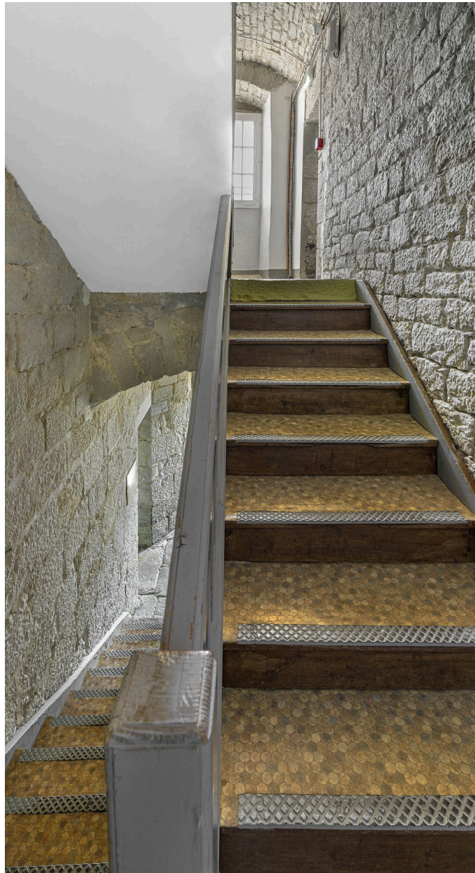
Caserne U : escalier tournant vers l'étage carré.
