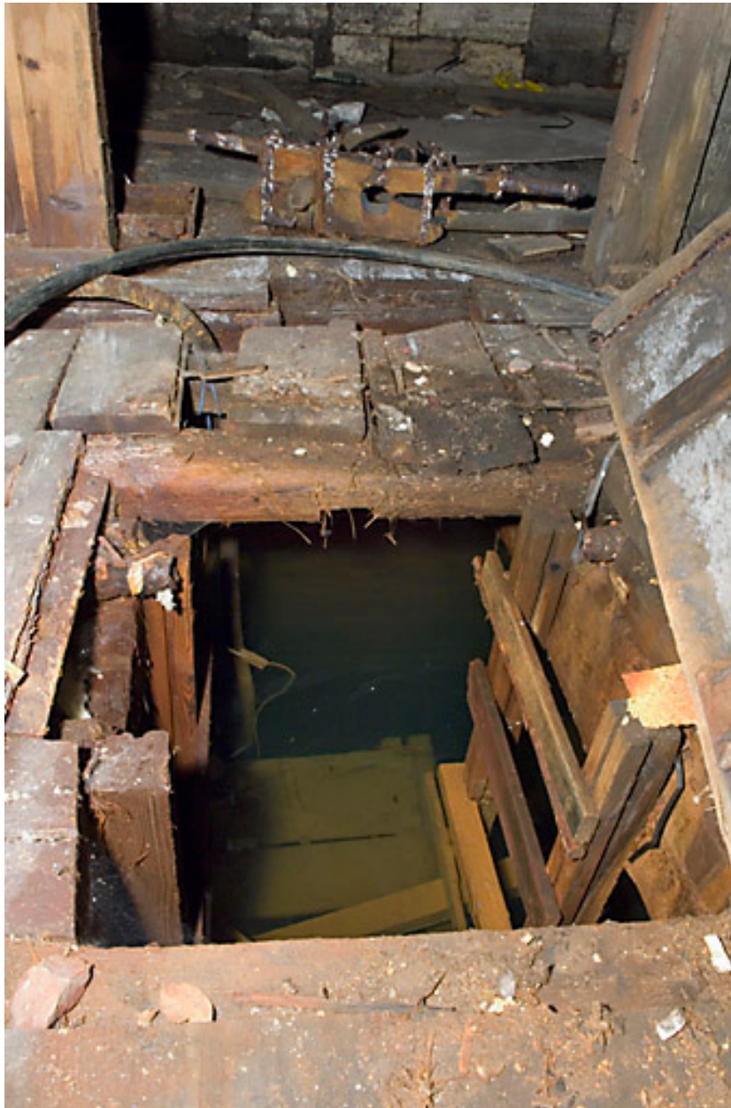
Grenier à sel. Plancher et trappe de la cuve des Allemands (2006).
