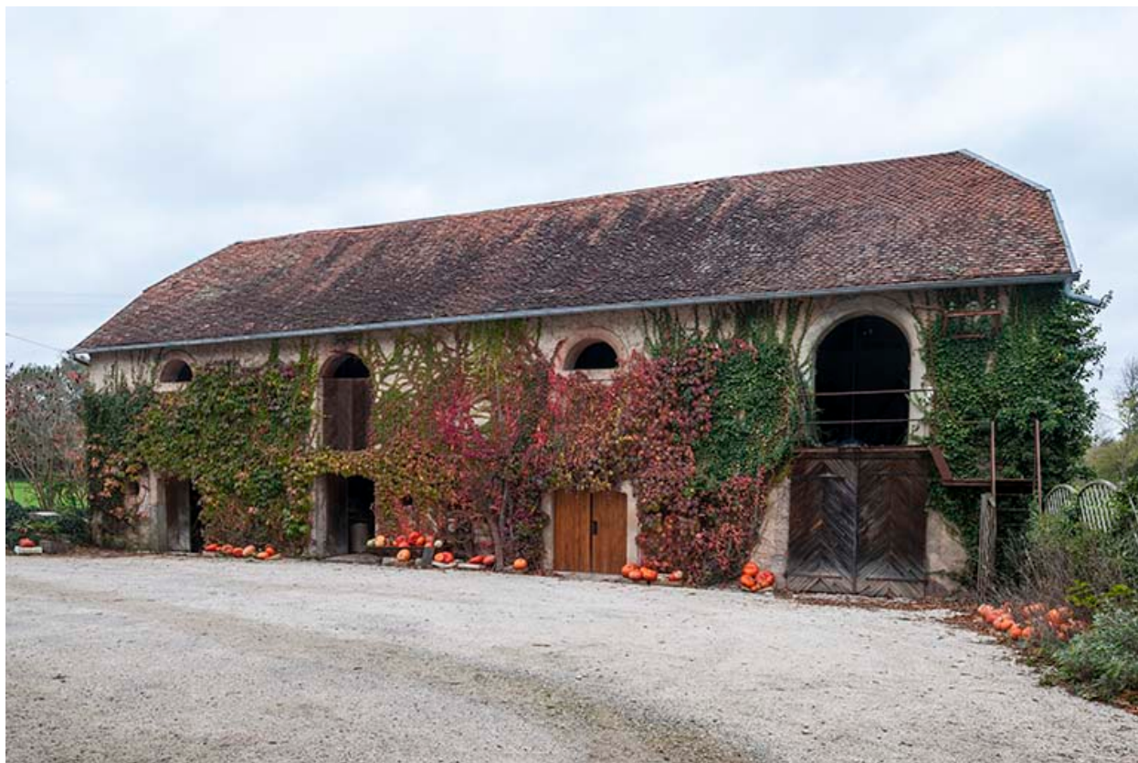
Façade est du bâtiment à fonction agricole.
