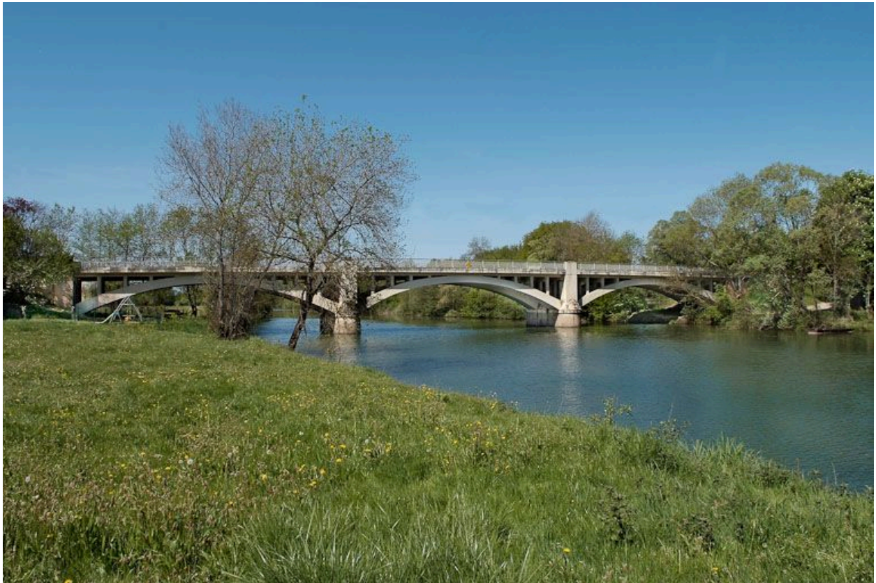
Pont routier sur la D933.
