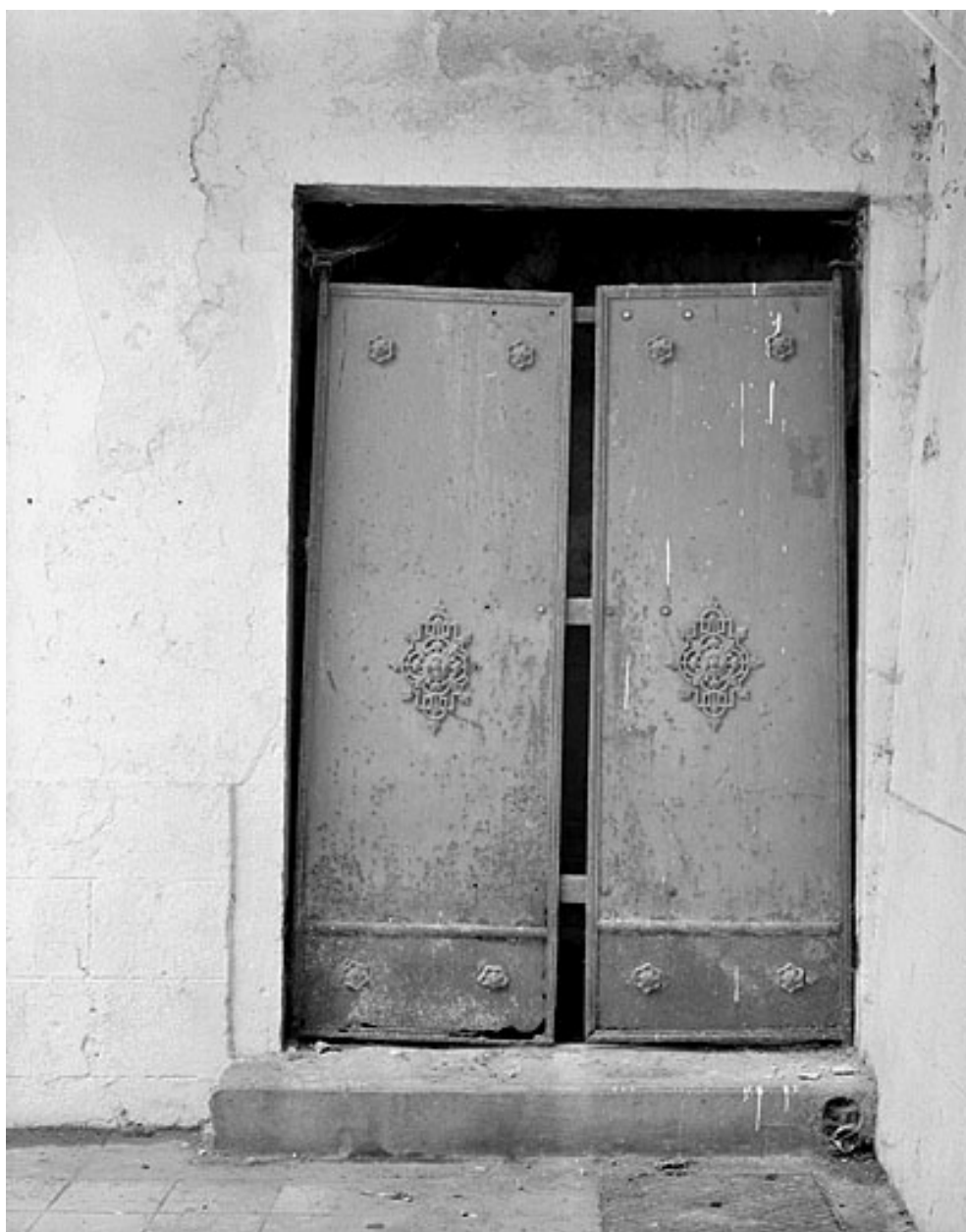
Porte dans la cour intérieure.
