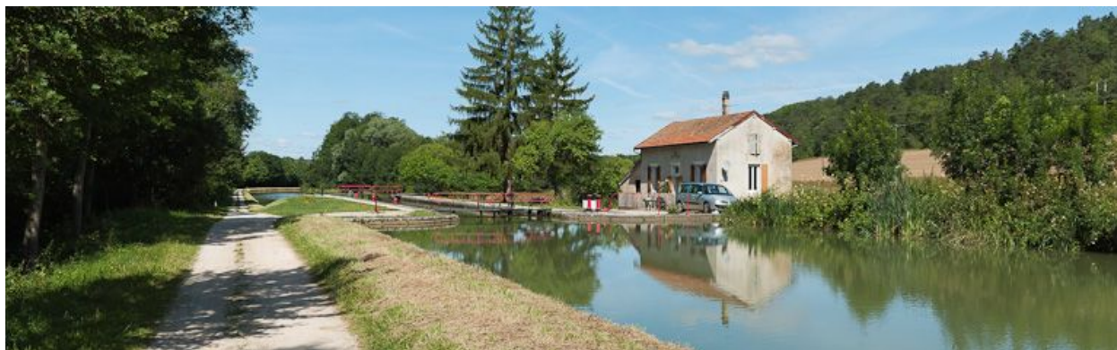
Vue d'ensemble prise d'amont.
