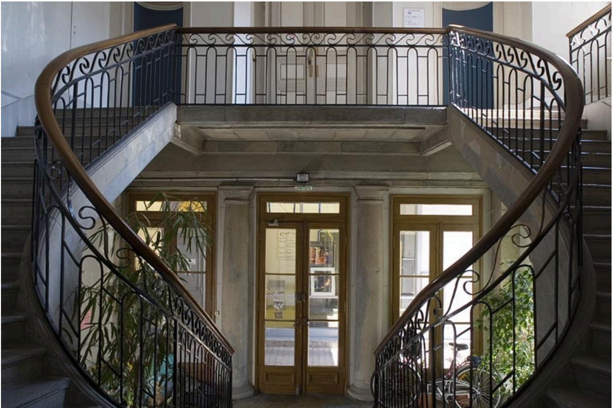
Vue d'ensemble de la rampe de l'escalier d'honneur.
