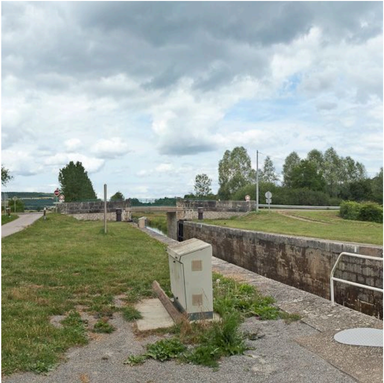
Vue du pont depuis l'amont.
