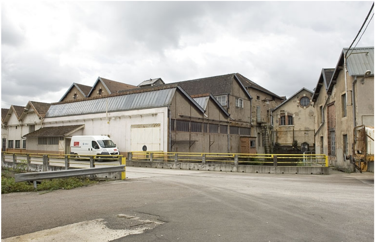
Atelier de fabrication (papeterie) et bâtiment d'eau.
