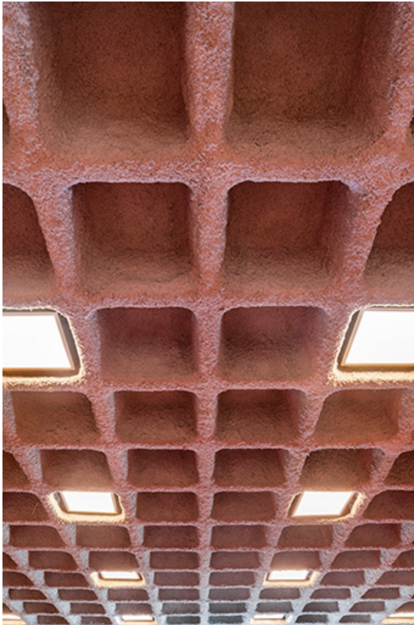
Petit Kursaal, salle : plafond à caissons.
