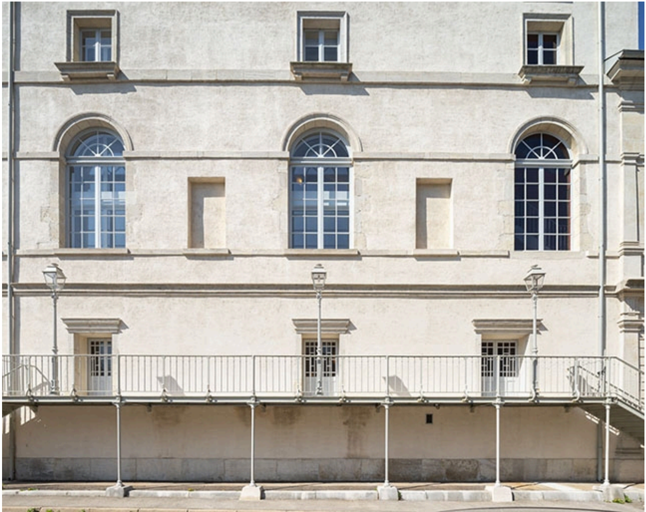
Corps central, façade latérale gauche : travées proches du corps d'entrée (au nord).
