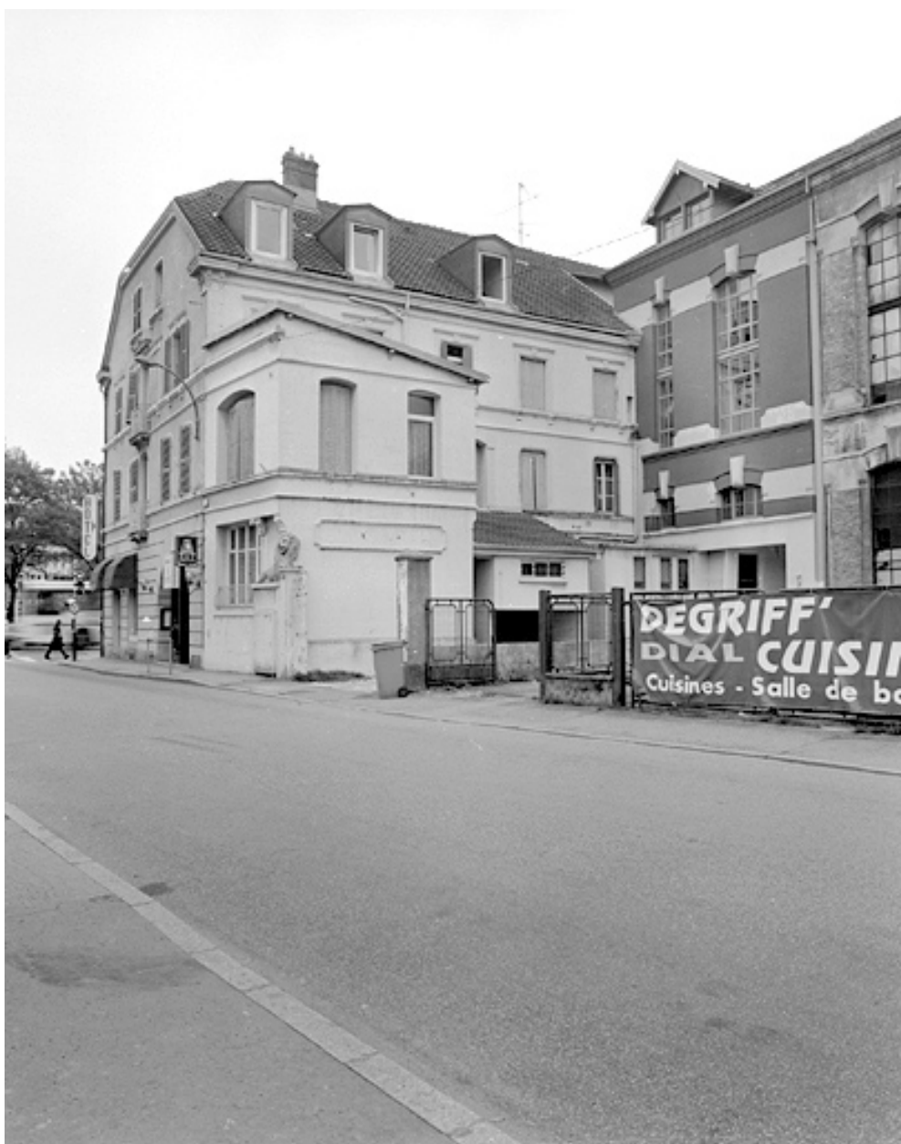
Bureau et façade de l'atelier de fabrication.
