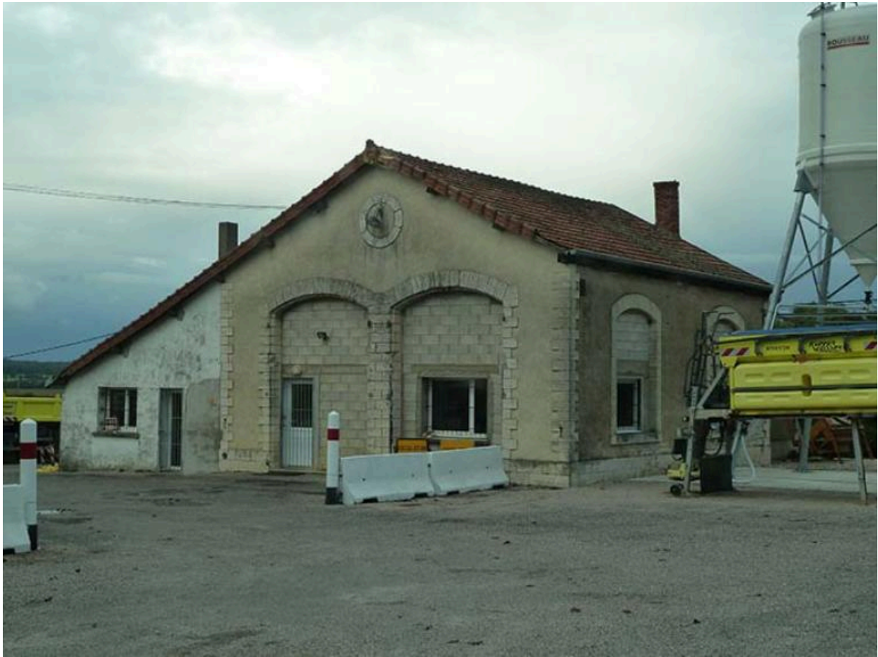
Bâtiment de l'ancienne gare
