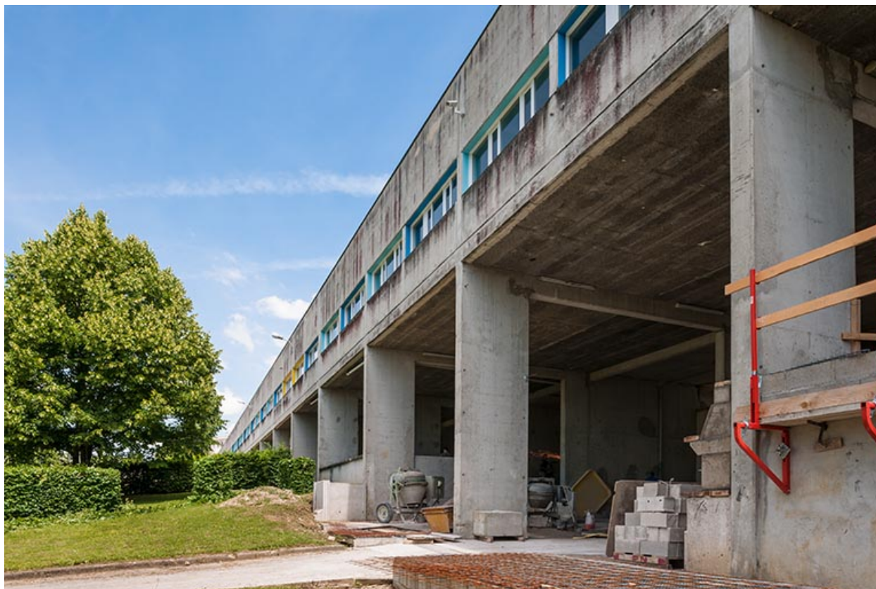
Externat : façade postérieure.
