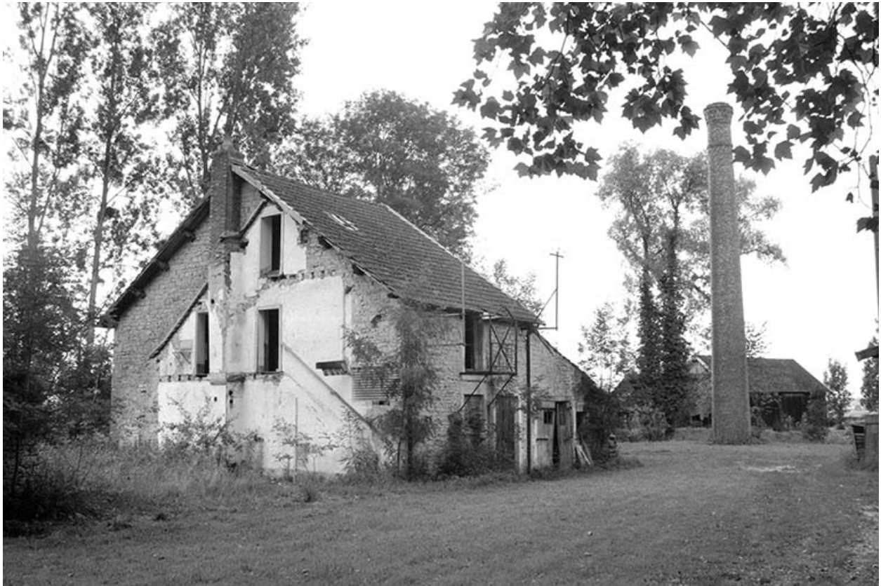
Ecuries (G) et cheminée d'usine (F).
