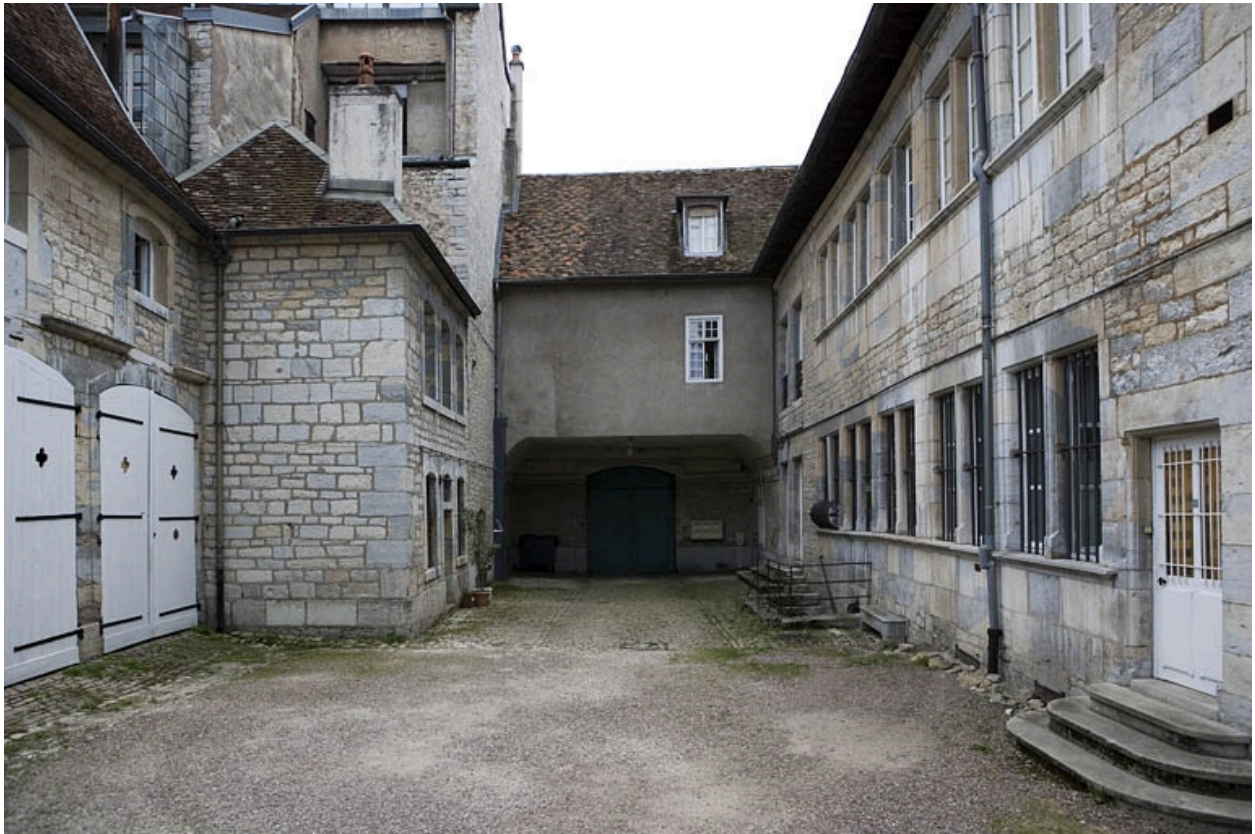
Vue d'ensemble de la cour depuis l'entrée du jardin.
