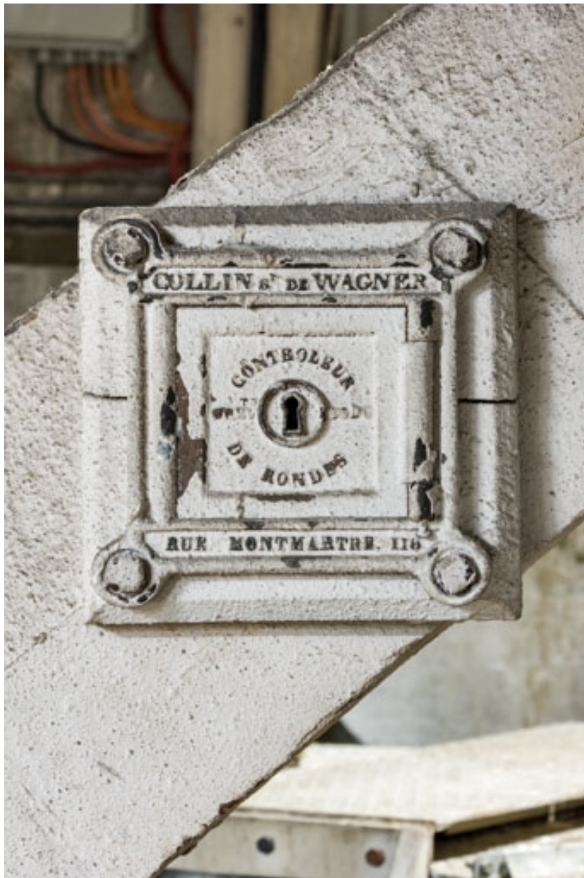
Contrôle de ronde Collin (successeur de Wagner, 116 rue de Montmartre à Paris), dans le comble au-dessus de la salle.
