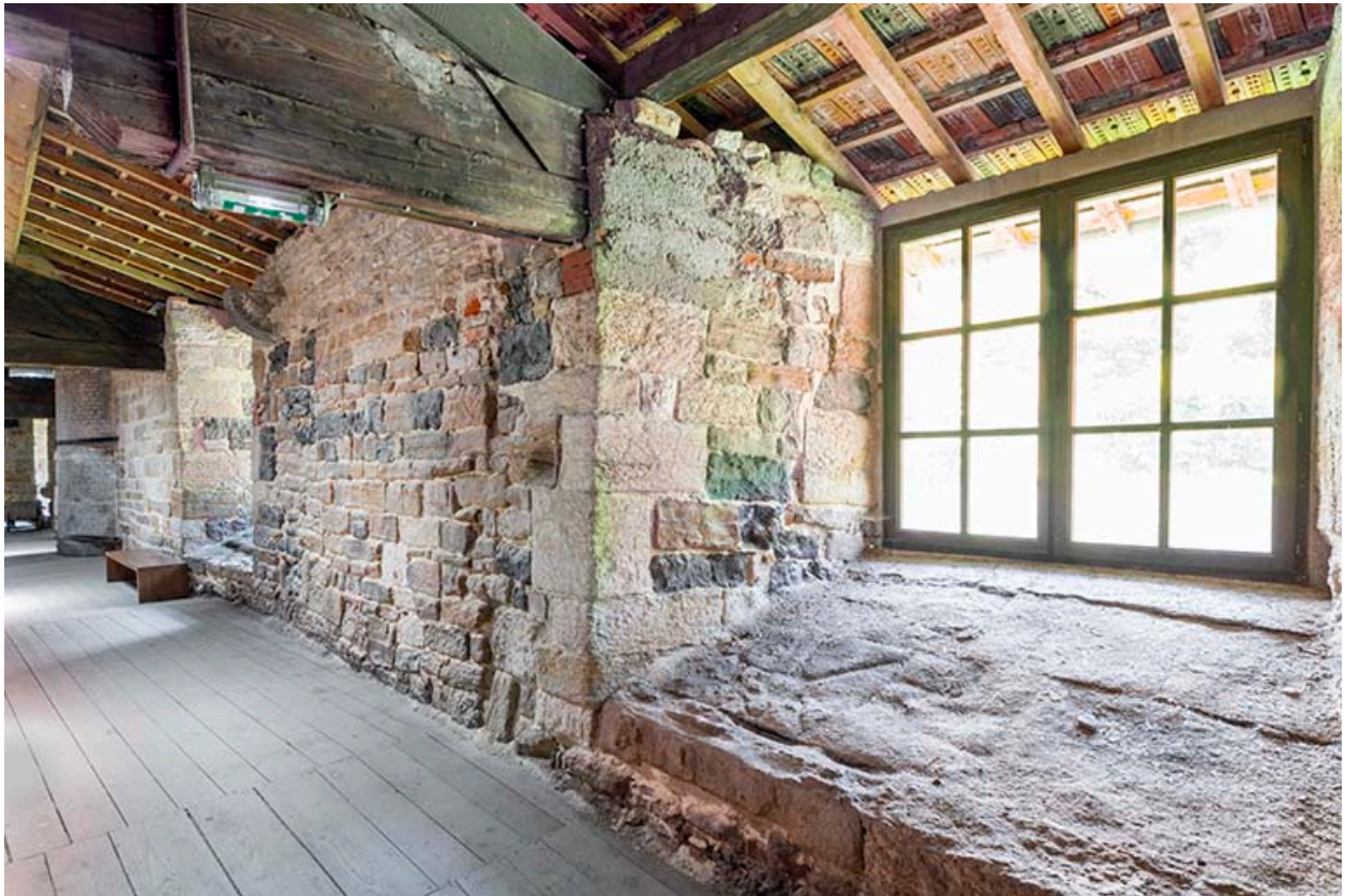
Mur ouest de la salle des poêles et embrasure de fenêtre.
