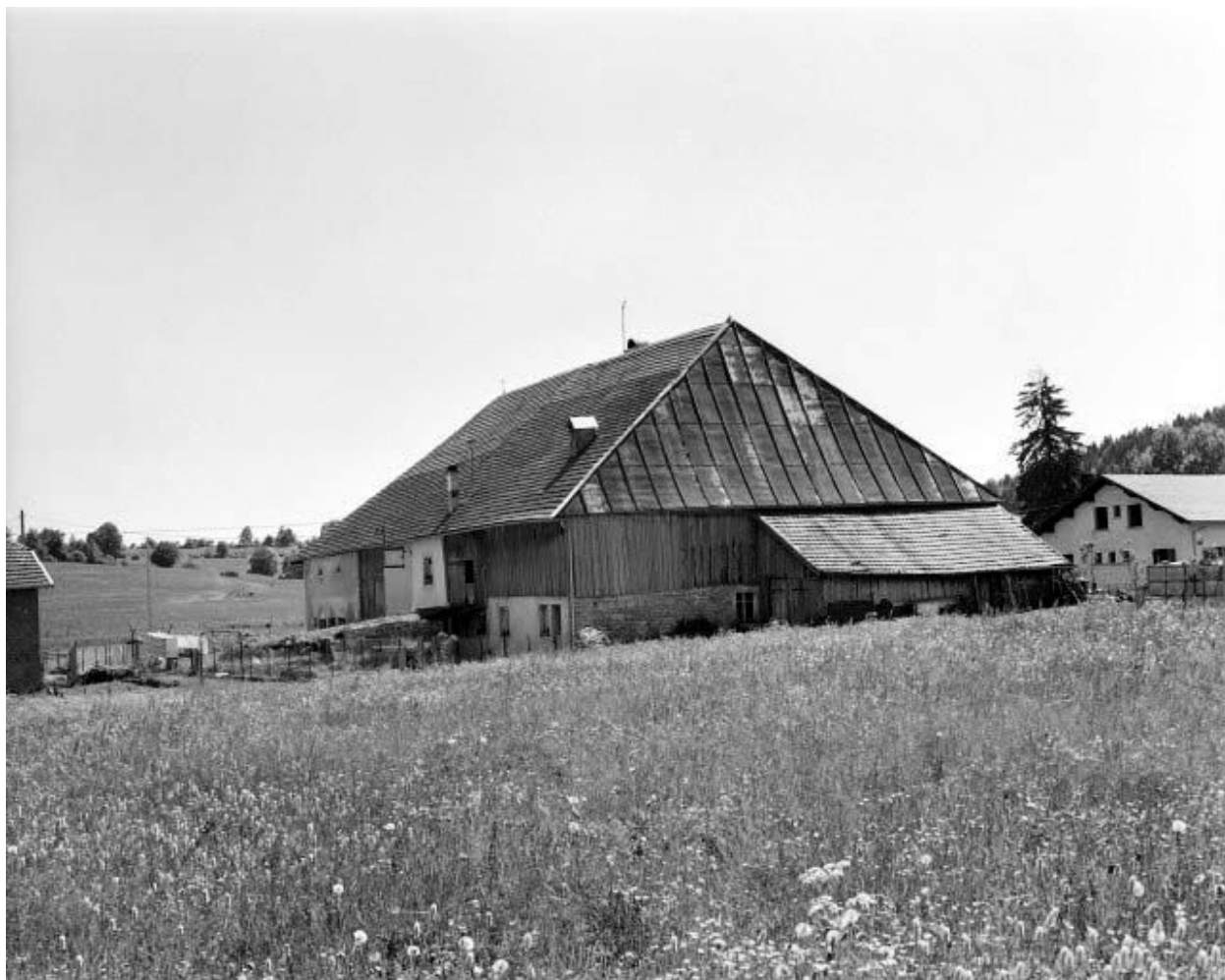
Façade antérieure et face latérale droite.
