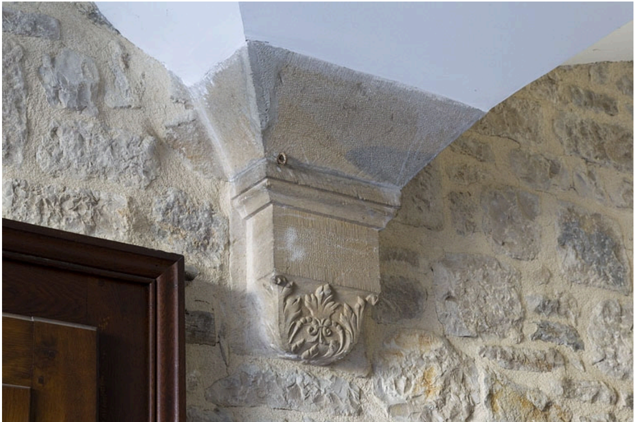
Logis principal, passage cocher : détail d'un support de la voûte.
