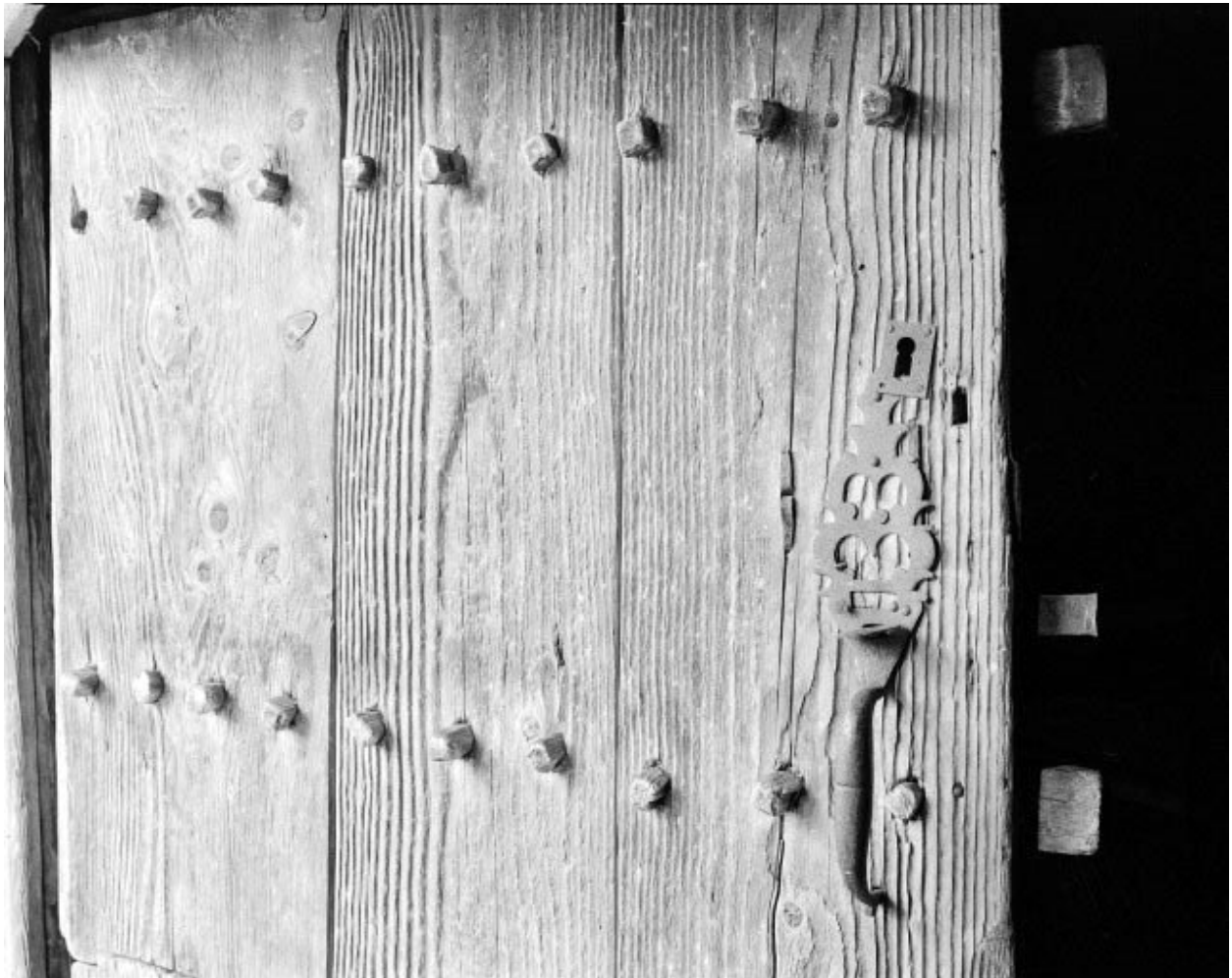
Façade postérieure en 1977, porte de grange gauche : poignée de porte.
